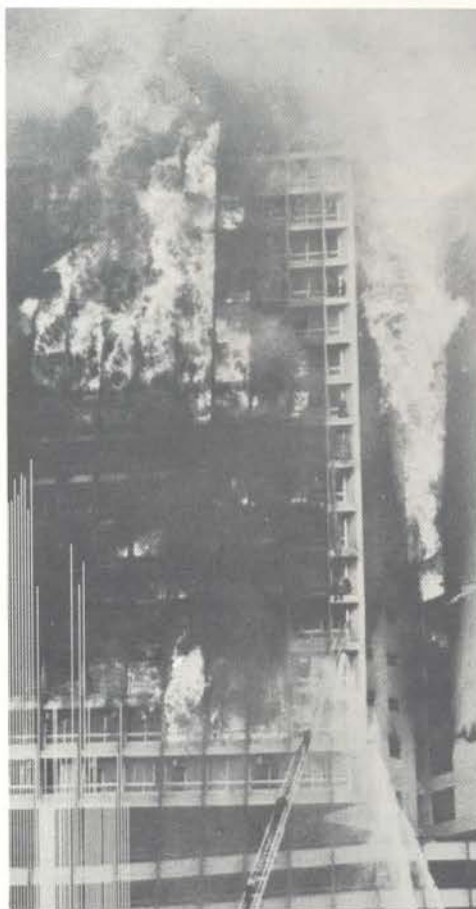
Edifício Andraus, em São Paulo, 24 de fevereiro de 1972: 21 mortos e 208 feridos. Edifício Joelma (foto), SP, 1º de fevereiro de 1974: 180 mortos, centenas de feridos.
