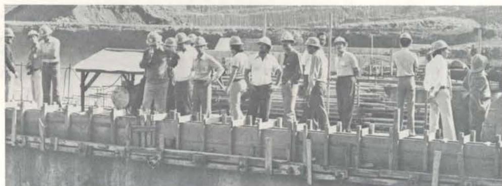
Antes da primeira sessão plenária todo o grupo realizou visita ao canteiro de obras e à Vila Residencial de Salto Osório.
