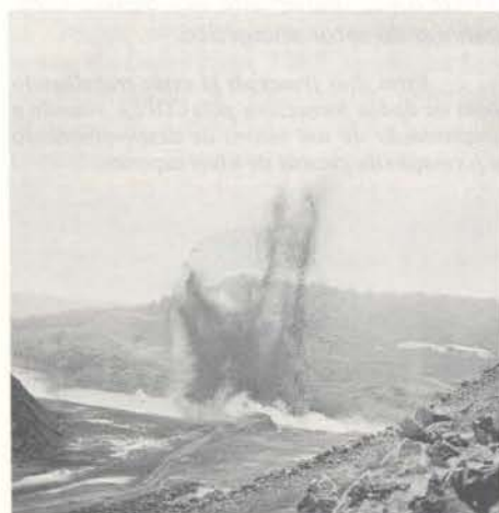
Poucos segundos depois, a explosão de mil e duzentos quilos de dinamite, pressentida em primeiro lugar por um leve tremor de terra seguido de grande barulho, ...
