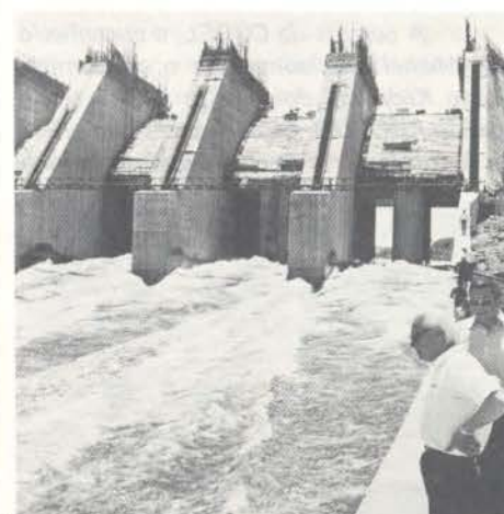
Pela primeira vez o vertedouro número 1 cumpriu sua função de fazer escorrer as águas do Iguaçu e era assegurada a continuidade dos trabalhos na construção da Hidrelétrica de Salto Osório.
