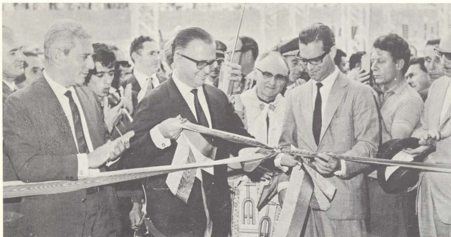
Acompanhado pelo Professor Parigot e pelo então Governador Paulo Pimentel, o General José Costa Cavalcanti — na oportunidade Ministro das Minas e Energia — descerra a fita, inaugurando a Hidrelétrica de Salto Grande do Iguçu (28.09.67).
