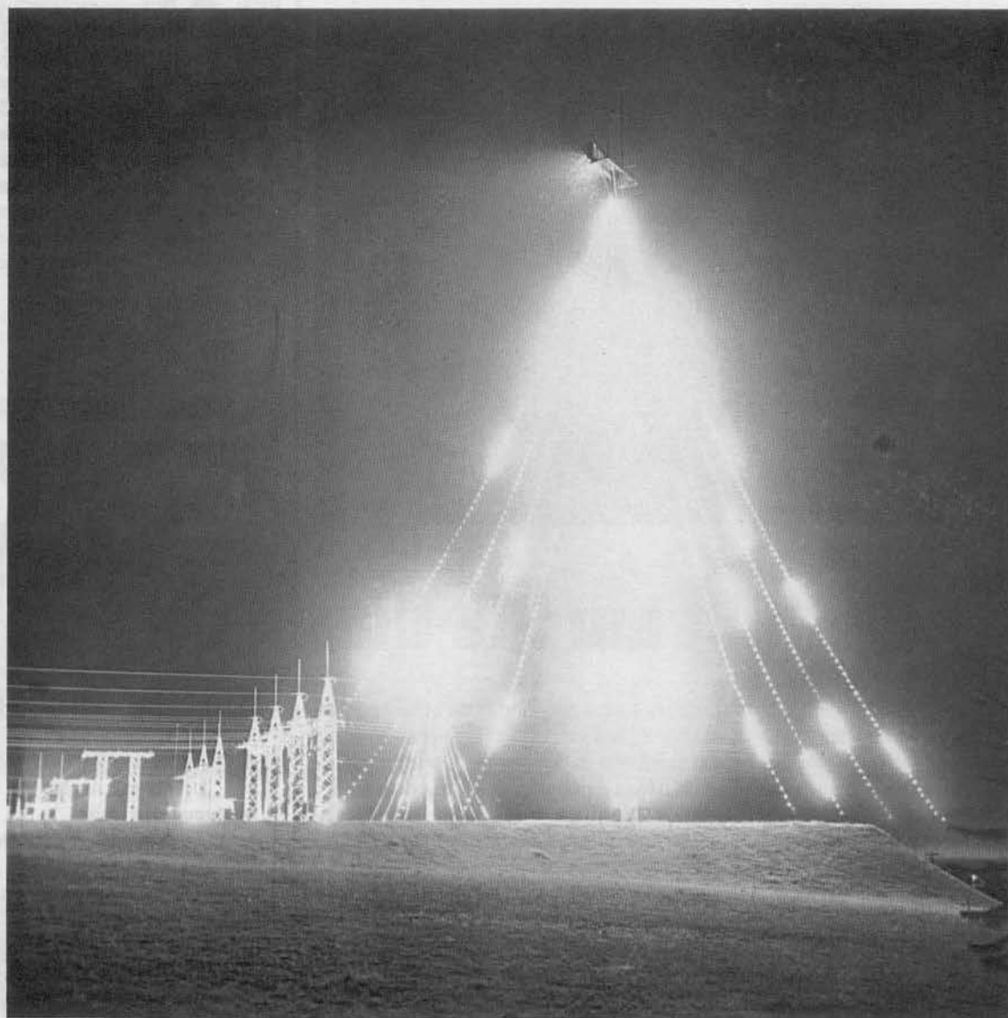
Subestação de Uberaba (Curitiba)
